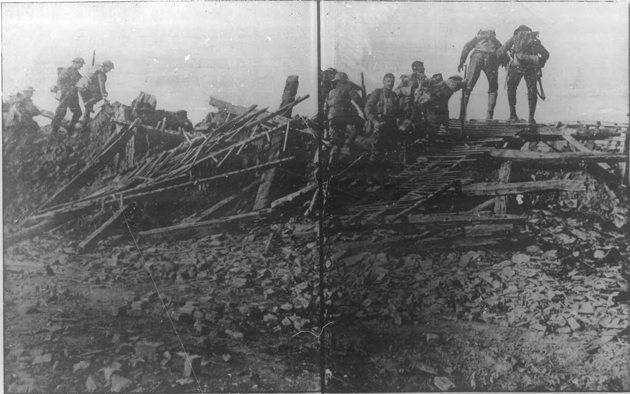
SOLDADOS INGLESES RECONSTRUYENDO UN PUENTE DURANTE EL AVANCE CONTRA LAS POSICIONES ALEMANAS.—(De una fotografía oficial).
